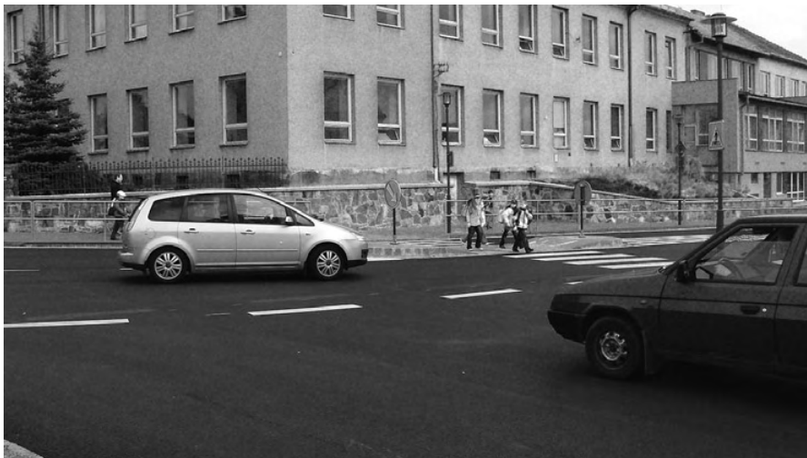
Nově zrekonstruovaná křižovatka.
