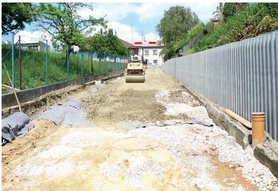
Pohled na upravovaný „ústavak“.
