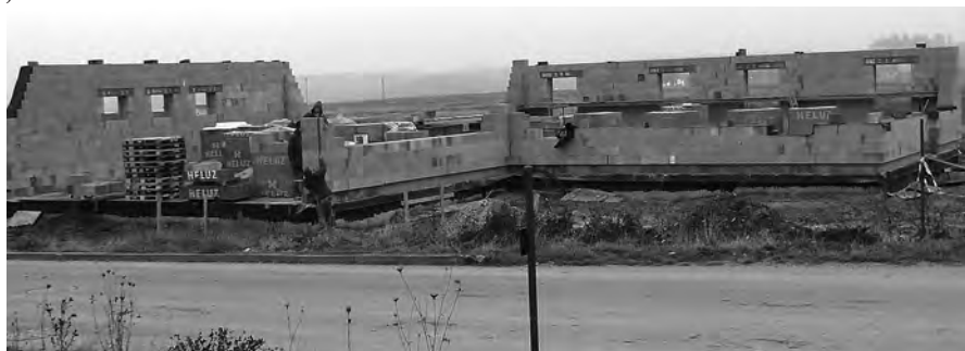
Výstavba ZZS Velká Bíteš.
