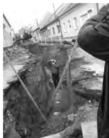
Pohled do výkopu. Foto: Táňa Horká
