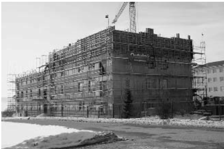
Na začátku měsíce února stavební firma zahájila práce na čtvrtém nadzemním podlaží, v prvním nadzemním podlaží v některých bytech jsou již dozděné i příčky mezi jednotlivými místnostmi
