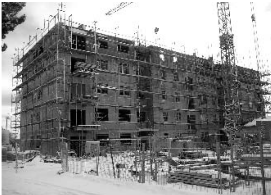
Pohled na dokončené vislé konstrukce pátého nadzemního podlaží od severozápadní strany.
