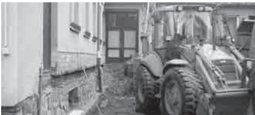
Průběh opravy přístupových schodů a rampy.
