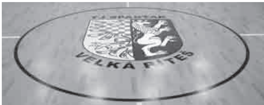
Pohled na opravenou podlahu.
