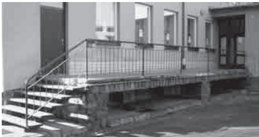
Rampa školy před opravou.
