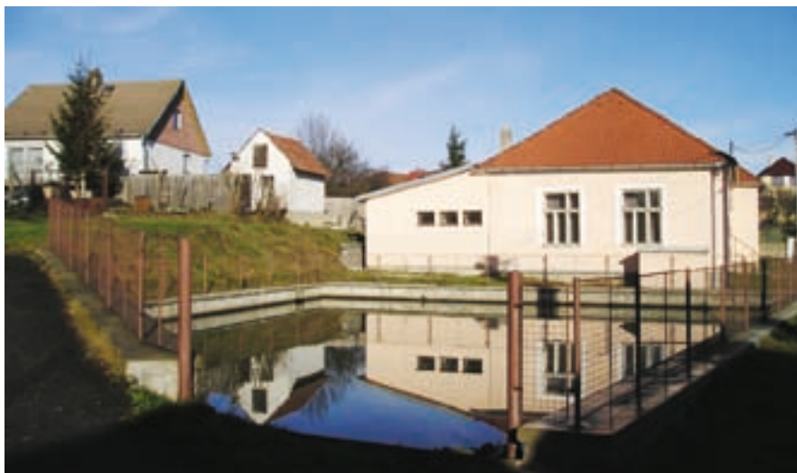
Bývalý hostinec „U Kopečných“ přestavěný na víceúčelovou budovu.
