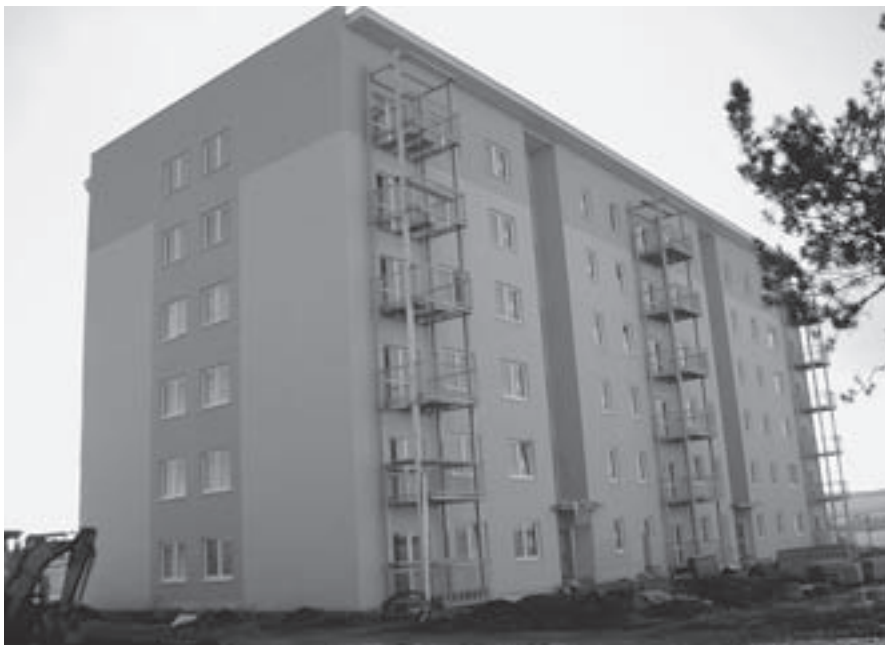
Pohled na západní stranu bytového domu.
