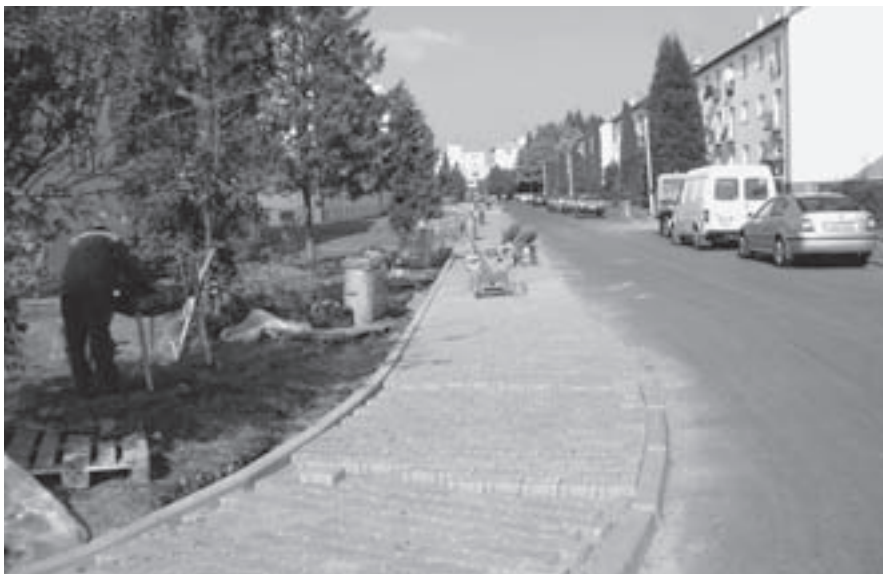
Pracovníci Technických služeb dokončují pokládku zámkové dlažby chodníku v ulici U Stadionu. FOTO: MGR. MIROSLAV BÁŇA
