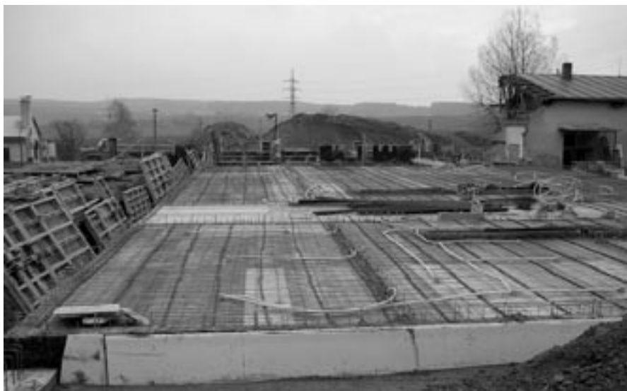
Dokončeno bednění a může se betonovat
