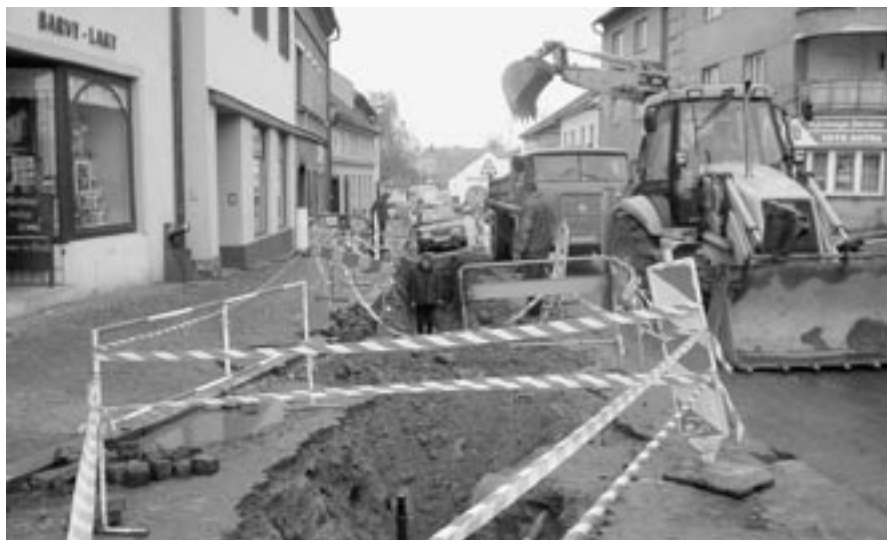
Pohled na odvodňovací příkop směrem do Lánic
