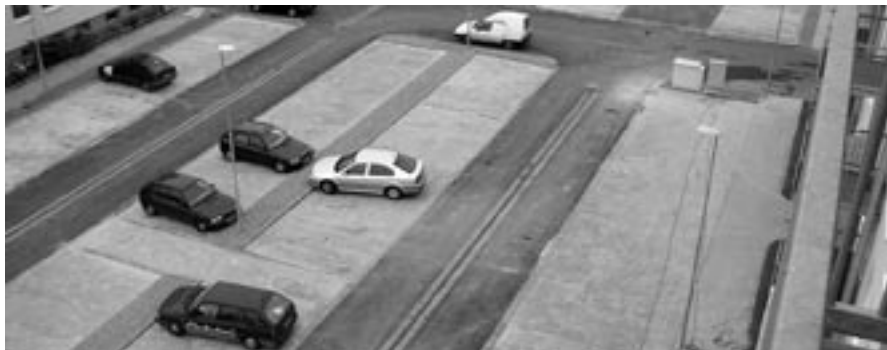
Pohled na ukončené parkoviště mezi bytovými domy.
