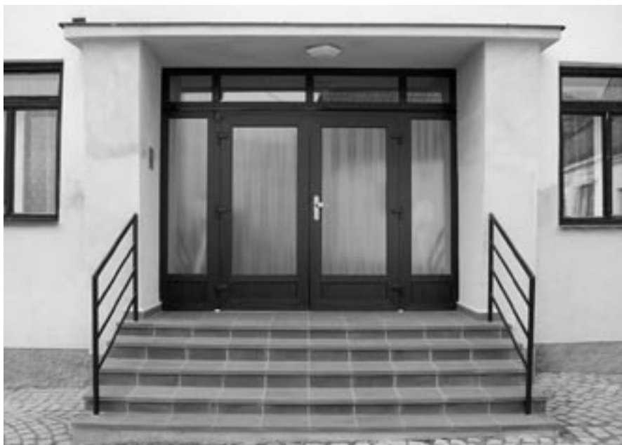
Pohled na opravený hlavní vchod z nádvoříčka MŠ.
