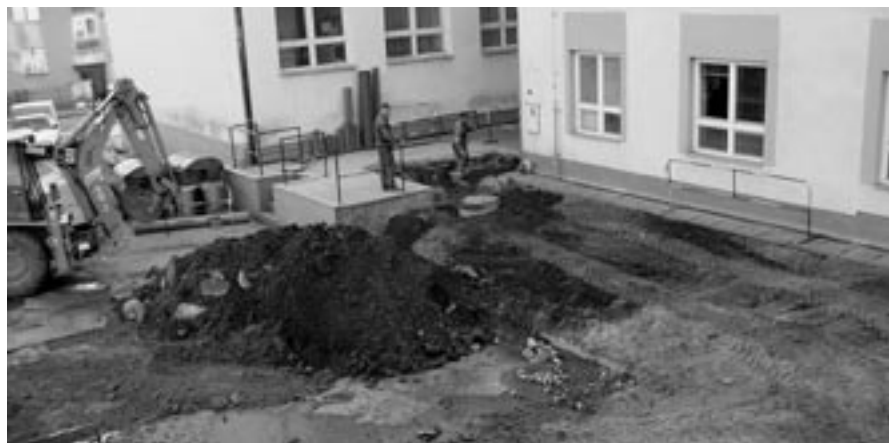
Pracovníci firmy dokončují propojení dešťového svodu a splaškové přípojky do nové revizní šachty. FOTO: MGR. MIROSLAV BAŇA
