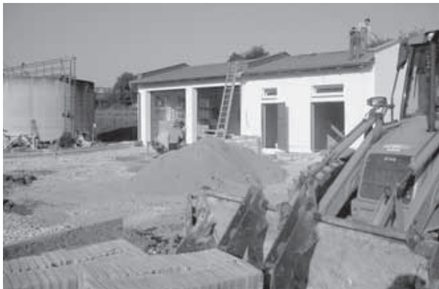
Stavba technického zázemí v závěrečné etapě dokončování.
