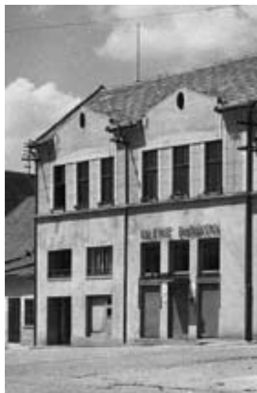
Vzhled domu č.p. 82 okolo roku 1940 po zbourání dřívějšího domu a postavení současného ve třicátých letech 20. století. FOTO: ARCHIV MUZEA
