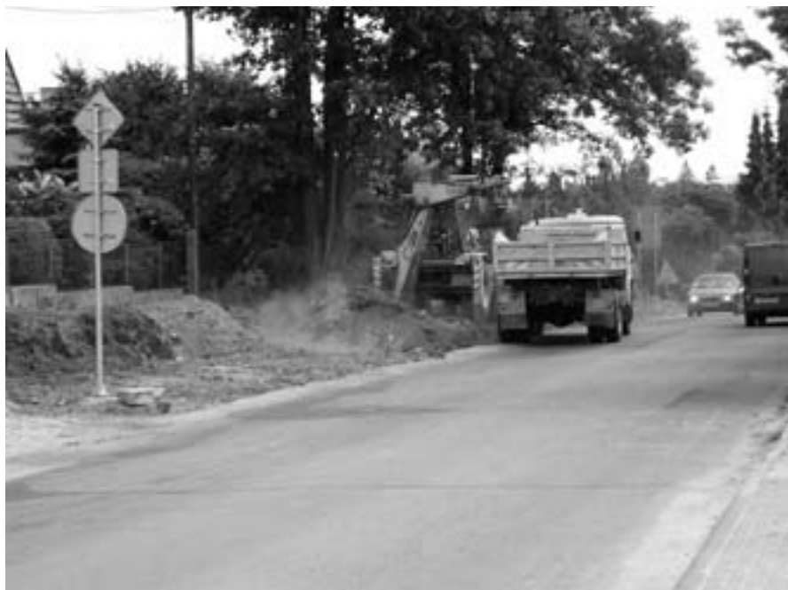
Stavební firma zahájila zemní práce.
