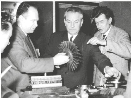
Zleva – technický náměstek Josef Ondrák, novátor František Hamr a ve- doucí konstrukce přípravků František Navrátil, diskutují nad možnostmi výroby kovové formy pro voskový model záběrníku. | Foto: Archiv PBS
