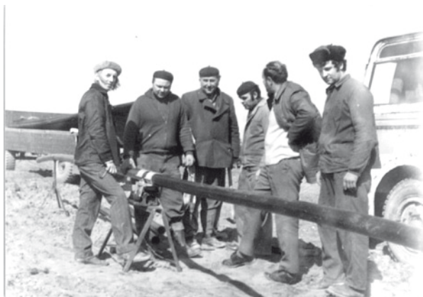
Výstavba obecního vodovodu v akci „Z“.
