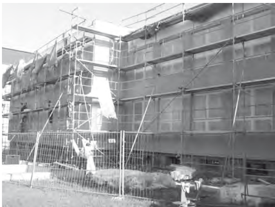
Zateplování jižní fasády MŠ U Stadionu. Foto: Ing. Pavel Bednář
