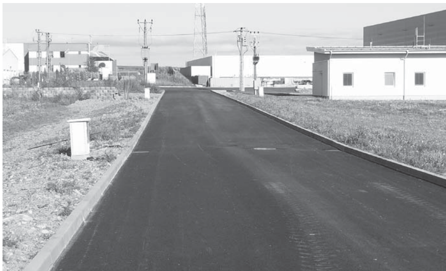
Nově dokončená účelová komunikace.
