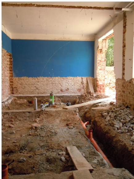
Pohled ze začátku stavby 3. 7. 2012.
