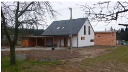
Výstavba RD na připravených parcelách.
