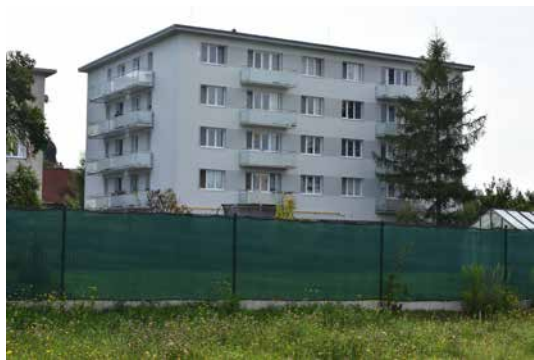
Opravený bytový dům. | Foto: Josef Jelínek
