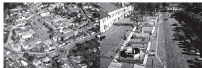
Rekonstrukce Masarykova náměstí a okružní křižovatka Na Valetce.
