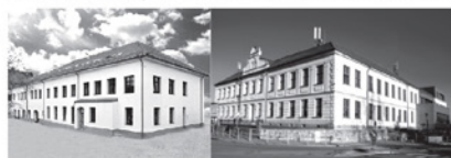
Rekonstrukce Matejské školy.
