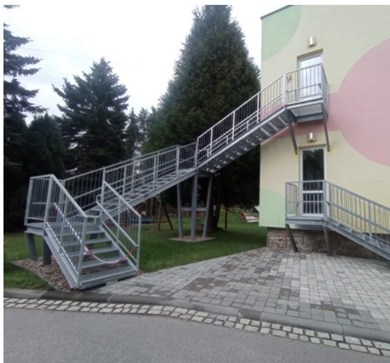
Únikové schodiště MŠ. | Foto: Archiv MŠ
