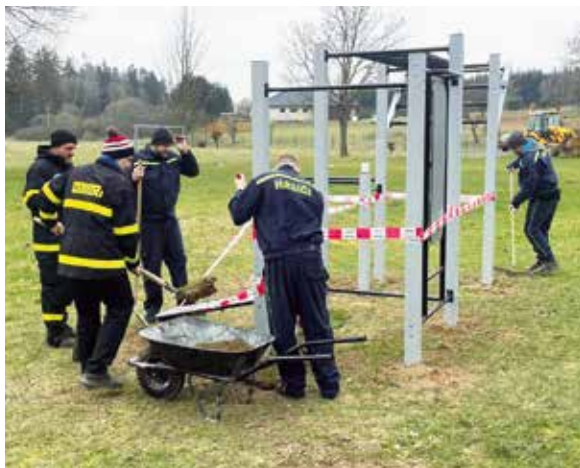
Z instalace. | Foto: Martin Brym
