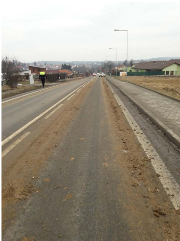
Obrázek 3 Znečištěná pozemní komunikace - ul. Jihlavská
