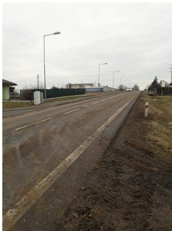
Obrázek 4 Znečištěná pozemní komunikace - ul. Jihlavská
