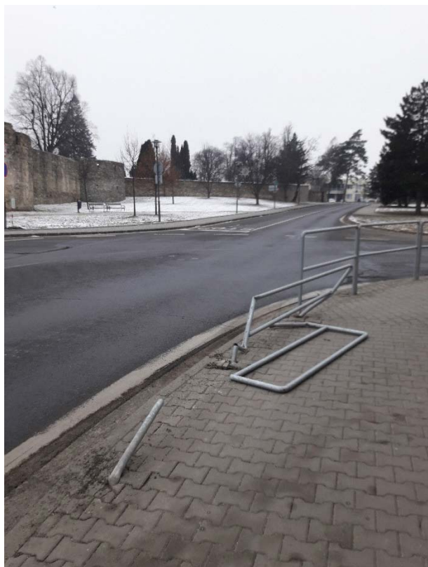
Obrázek 3 Poškozené zábradlí - ul. Na Valech
