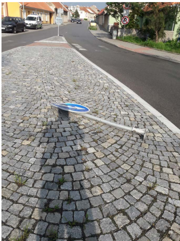
Obrázek 1 Poškozená dopravní značka - ul. Lánice
