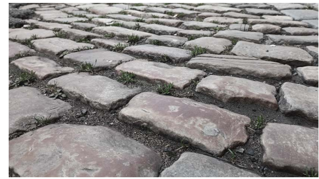
dlažební kostky mírně nakloněné vůči svahu
