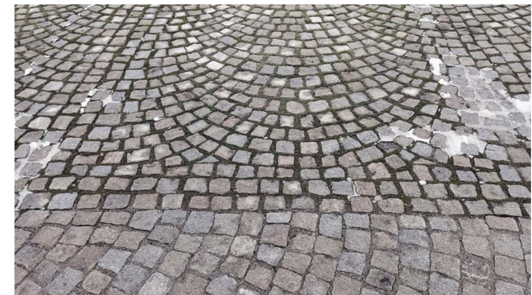
skládání dlažby do vějířů
