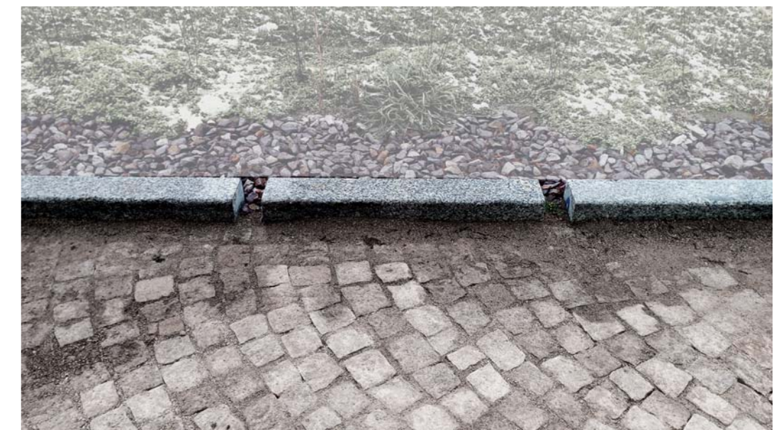
mezery mezi prvky obrubníku ponechávají volný průchod vody do trávníku
